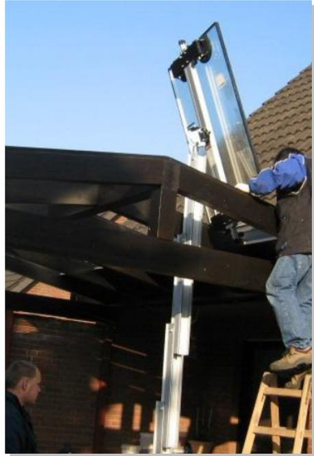
Mit der kompakten EASYLIFT Glasmontagehilfe können 2 Personen problemlos große und schwere Scheiben in Dachkonstruktionen verbauen. Dank der flexiblen Abstützungen kann das Gerät auf Stufen oder bei Unebenheiten eingesetzt werden.
