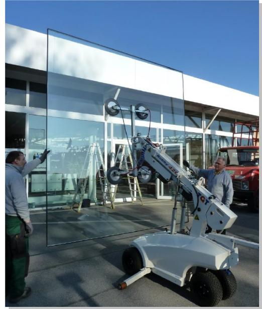
Der kompakte TGT ROBBY 420 verfügt über ein Spezialknickgelenk, damit große Scheiben seitlich am Gerät durch schmale Türen gefahren werden können!
